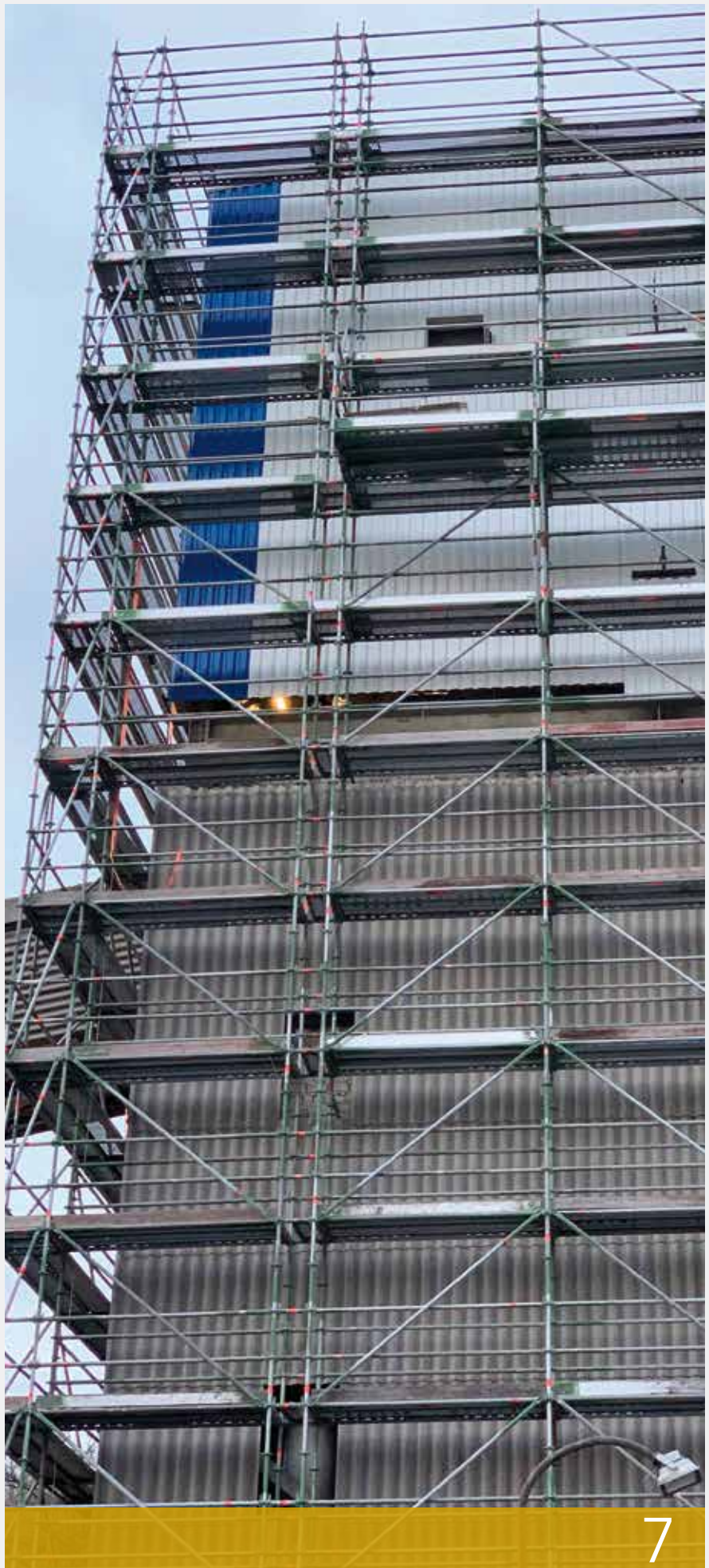
7. RISTRUTTURAZIONE DELLA FACCIATA DELL'EDIFICIO DEL CARICO SFUSO RECLADDING OF THE BULK LOADING BUILDING
